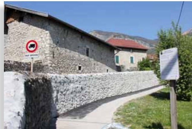
Mur après travaux
