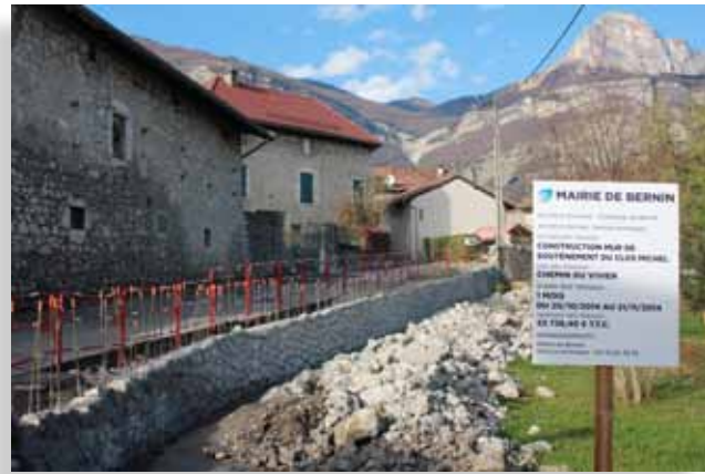
Pendant les travaux
