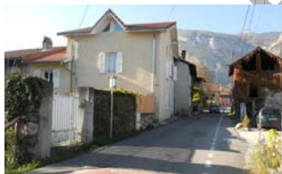
Alignement et murs sur RD
