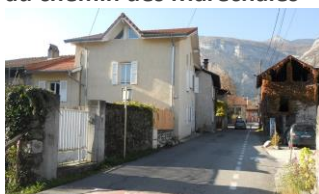
Alignement et murs sur RD
